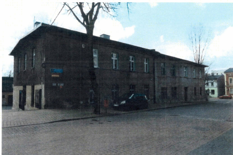
elewacja północna budynku
