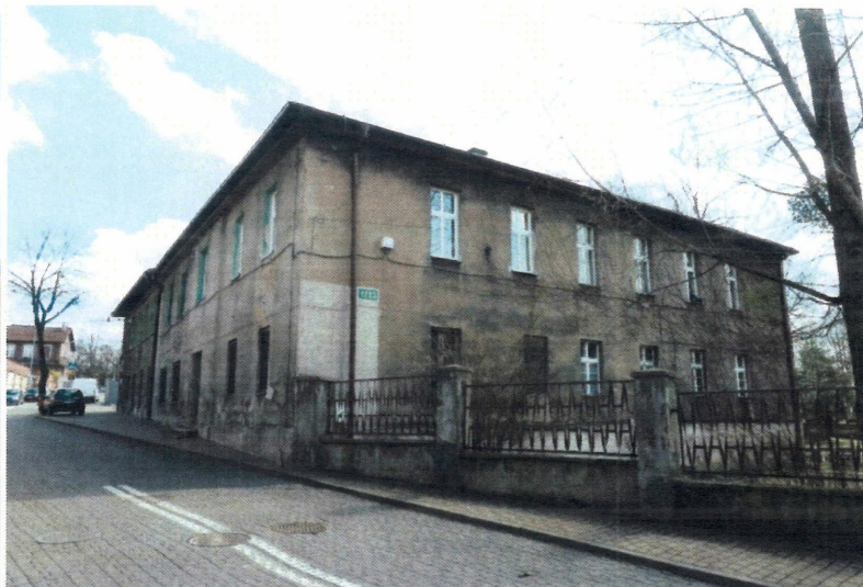
elewacja zachodnia budynku
