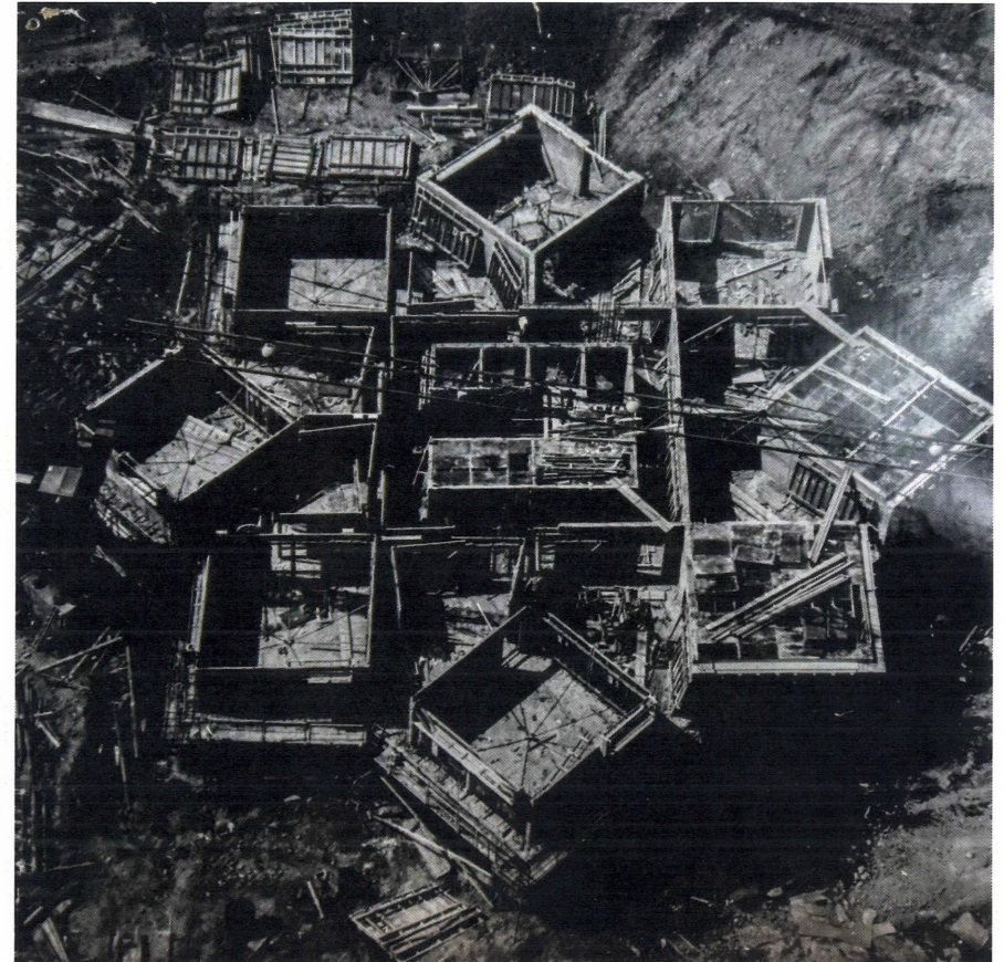
Budowa jednego z wieżowców mieszkalnych (lata 70. XX w.) (źródło: Archiwum Urzędu Miasta Katowice)
