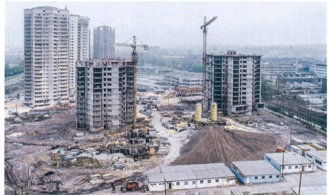
Budowa osiedla – ok. 1980/1981 r. (źródło: Archiwum Urzędu Miasta Katowice)
