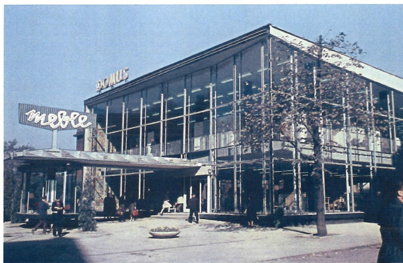
budynek na zdjęciu z ok. 1970 r.
