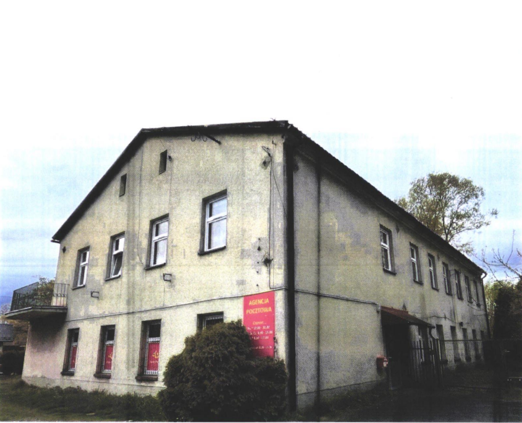
Widok od strony północno-wschodniej.
