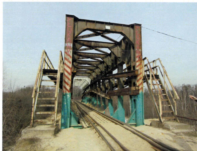
widok od strony południowej
