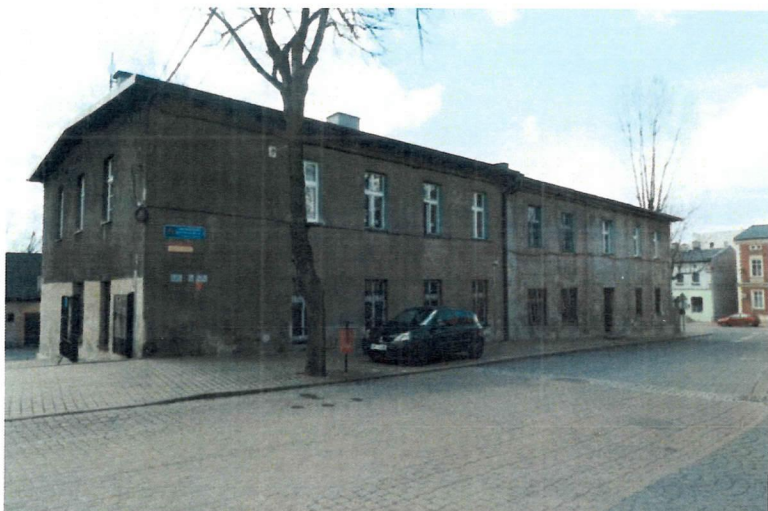
elewacja północna budynku
