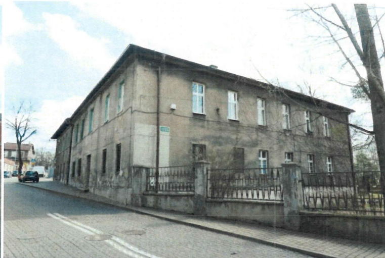
elewacja zachodnia budynku
