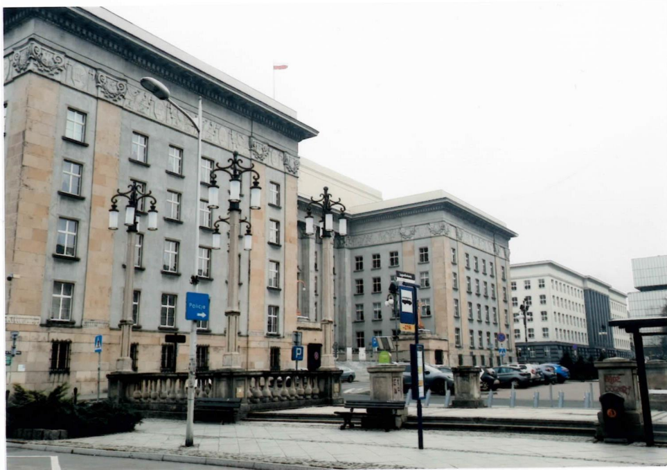
Widok w kierunku południowo-wschodnim
