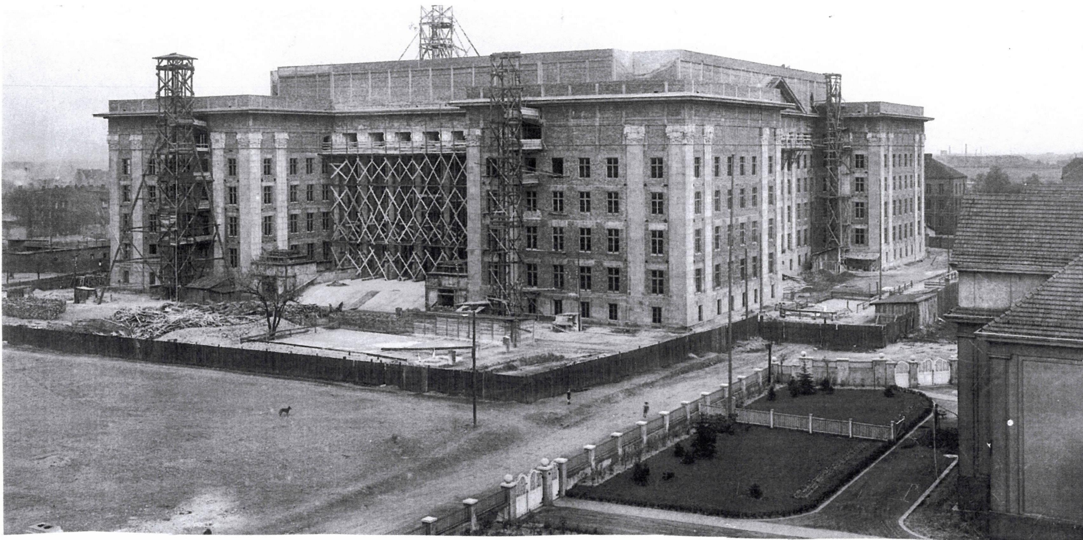
Budowa Śląskiego Urzędu Wojewódzkiego 1926 r.
